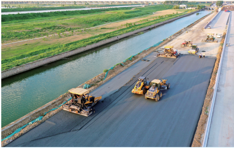
近日,沭阳县环城快速路项目建设如火如荼。施工现场机声隆隆,多台机械正在铺路,工人及时在路面上铺设养护毯,有序推进项目建设,确保施工进度和工程质量。
