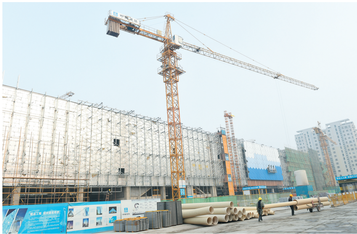
位于高新区潘黄街道境内的盐城万达广场项目，总投资达60亿元，占地面积276亩，是万达第五代商业运作模式产品，含购物中心、餐饮、国际连锁超市等多个项目，对于提升城市功能、完善商业配套具有极大的促进作用。该项目于去年12月份开工建设，今年9月份主体封顶。图为该项目施工现场。本报记者 丁晓岚 摄
