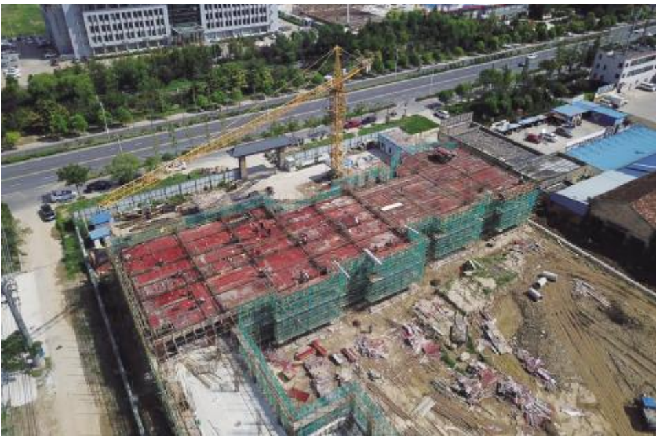
我县不断加大教育投入力度,加快教育基础设施建设,促进教育均衡化、优质化发展。图为总投资3500万元的县同心幼儿园项目建设现场。 盛诚 摄
