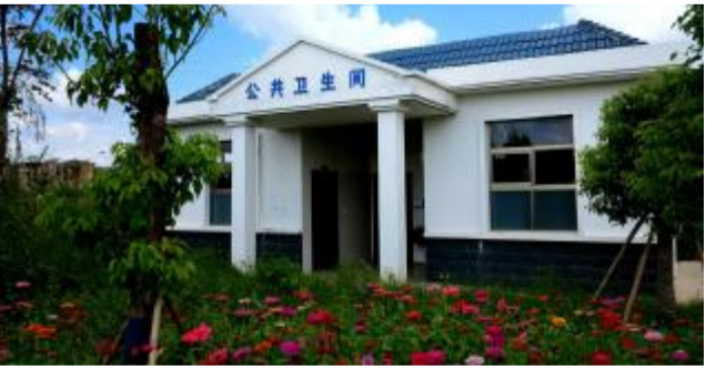
今年以来,我县大力实施“双百”工程,着力把公共卫生间建设从城市向农村拓展,即农村集镇规划建设一类公厕100座,乡村规划建设三类以上公厕100座。既改善环境方便群众生活,又成为农村一道靓丽的风景。图为特庸镇新建的一类公共卫生间。 施亚平 林雨 摄
