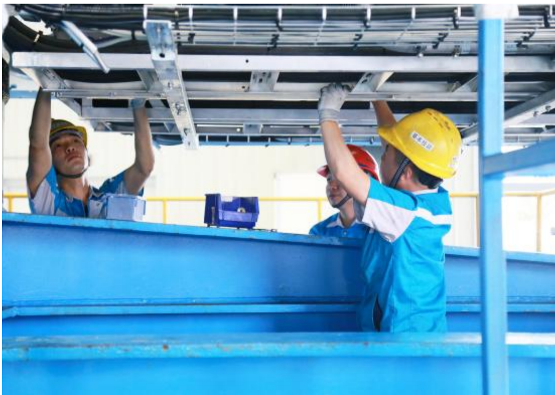
射阳经济开发区以创新驱动为抓手,以质量效益为中心,不断推进重大项目建设,以实际行动贯彻落实县委十五届五次全会精神,掀起大干当前的热潮。图为远景能源有限公司工人正在组装海上风机。
