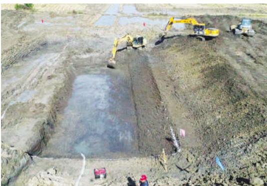
图为县国土资源局在黄花镇实施的“点穴式”扶贫项目施工现场。通讯员 张建雄
