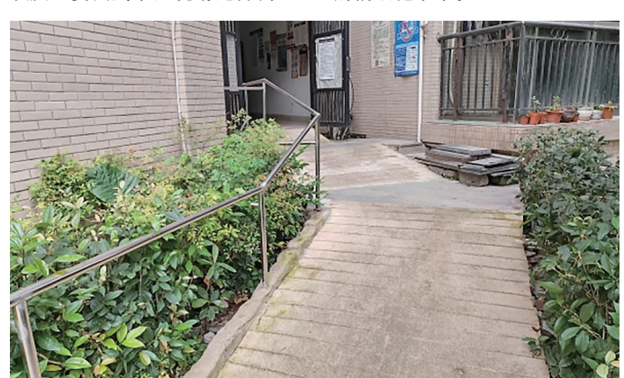
尚阳康城小区楼道增设的无障碍通道
