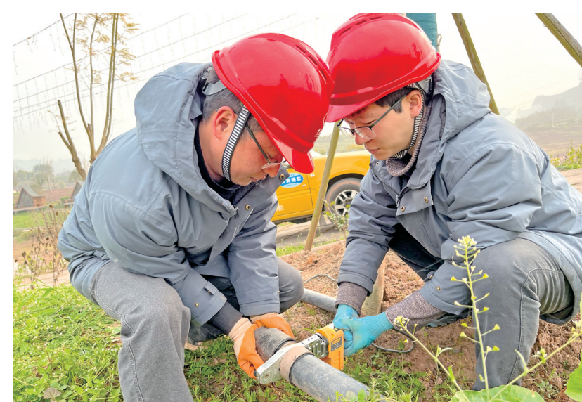
两江水务牛头岩水厂工对木耳镇新村花田坝子管网进行抢修
