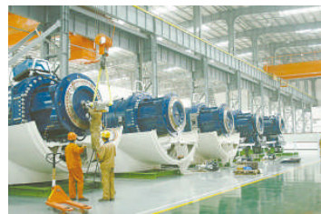
2009年5月1日,华锐风电产业园基地1.5兆瓦风电机组正式下线。
