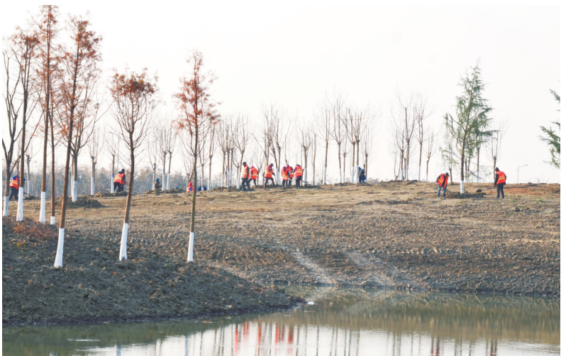
龙冈镇以盐龙湖周边已栽植到位的生态防护林为基础,按照“全年有绿、二季有香、三季有花、四季见彩、不见裸土”的原则,加快实施盐龙湖“一片林”提升工程,大面积栽植高杆乔木,增设游憩和功能配套设施,打造“林木葱翠、林水相依、园湖一体”的饮用水源保护地。图为工人们正在栽植树木。本报记者 卓玲 摄
