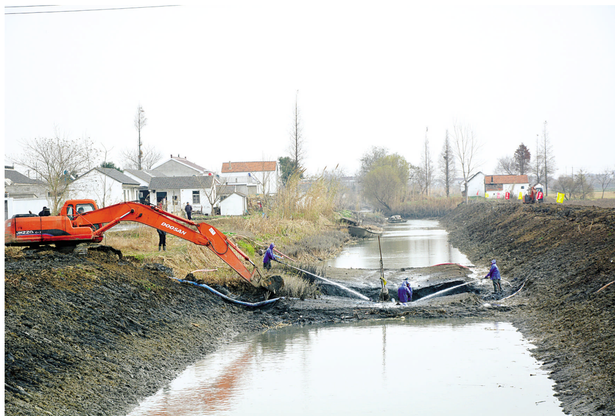
近年来,郭猛镇不断加大农村环境综合整治和水利建设力度,至目前已累计疏浚河道150公里,加固圩堤40公里,新建防洪墙5公里,新建排涝站4个、灌溉站35个。图为该镇护西村生产河集中连片整治的施工现场。本报记者 宋进波 摄
