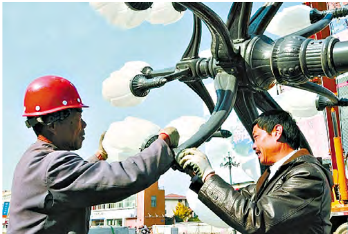
11月24日记者获悉,建军路地下人防商业街工程的一阶段工作已经基本结束,建军路路面已经基本摊铺结束,预计在本月底实现通车。对此,记者就市民关心的相关话题,采访了建军路地下人防商业街建设指挥部的现场负责人。图为建设工人正在建军路施工现场安装路灯。(来源:盐城晚报)
