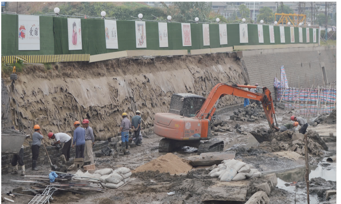
为进一步提升城市形象,改善人居环境,市水利局积极推进黑臭水体治理工作。连日来,位于滨江新城北片的三元沟整治工程如火如荼,桩基工程、清淤工程等已完成,污水管道铺设约800米,完成总工程进度的40%。该工程于今年8月份开工,预计年底竣工。图为10月10日施工现场。 窦月摄
