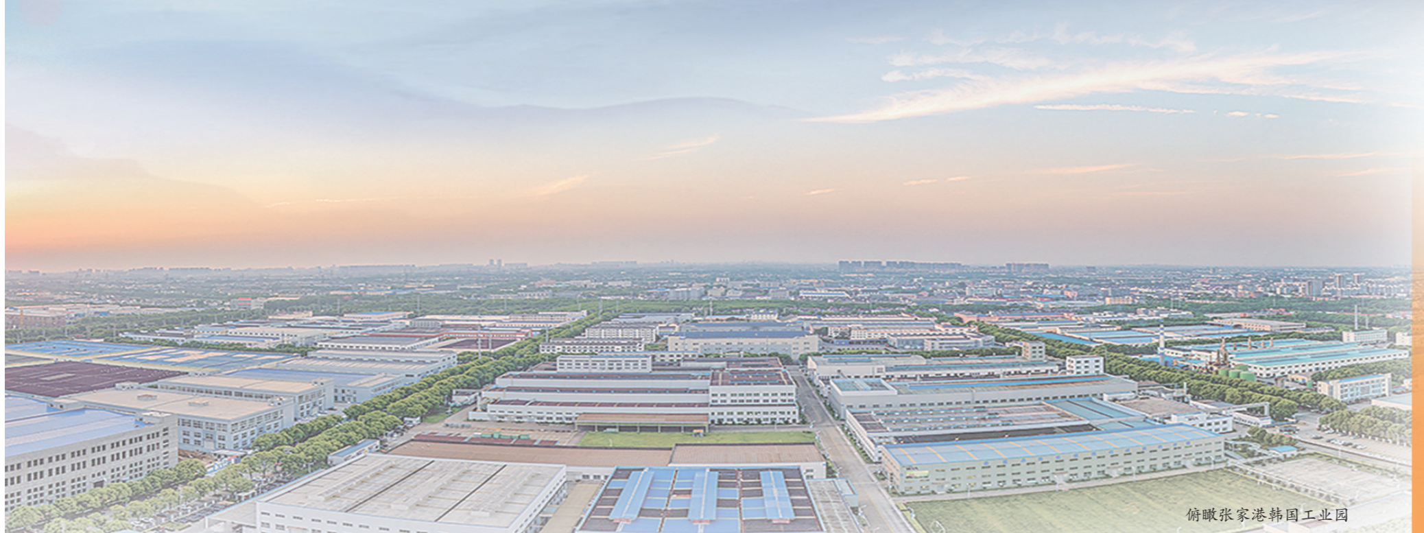
俯瞰张家港韩国工业园
