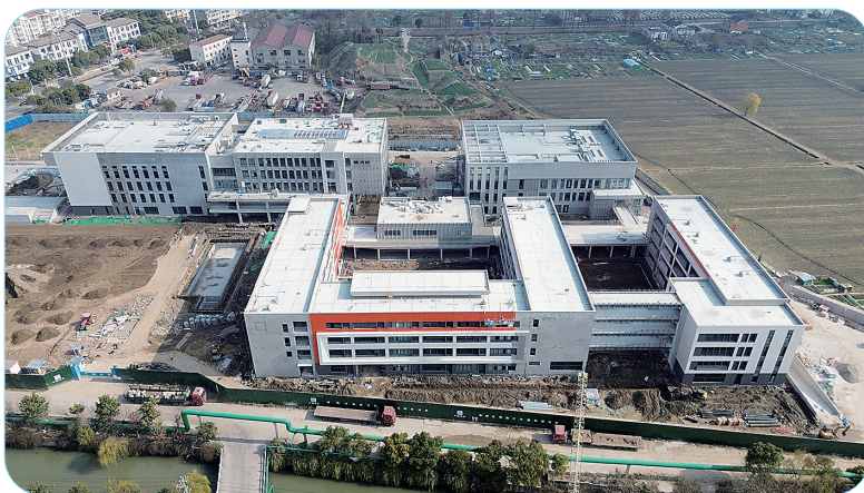
香山小学建设现场
